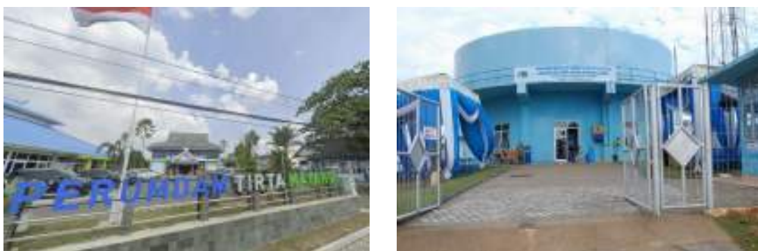
Gambar 3.2.25 Fasilitas Air Minum Perpipaian di Kota Jambi
